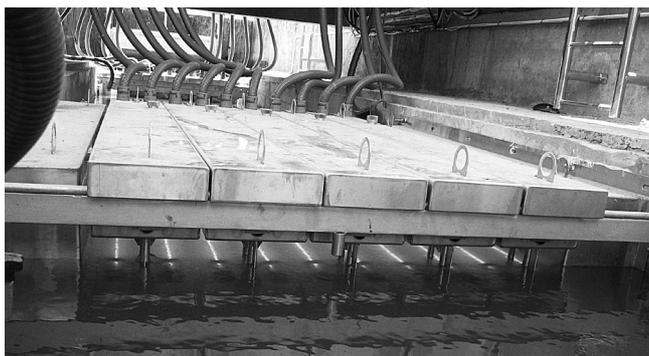
Рис. 4. Камера обеззараживания в виде открытого бассейна на станции очистки сточных вод в Гадонг (Бруней)
